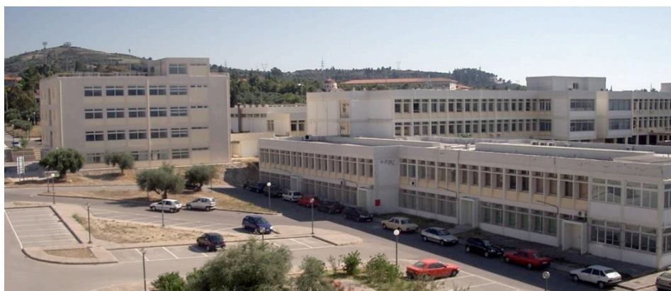
Βορεινή όψη κτηρίων Τμήματος: Διακρίνεται δεξιά το συγκρότημα των Κεντρικών κτηρίων και αριστερά η Επέκταση
