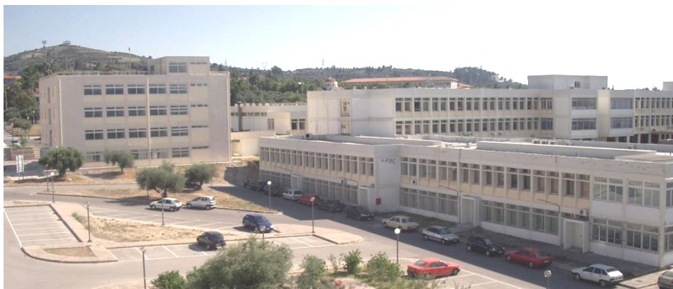
Βορεινή όψη κτηρίων Τμήματος: Διακρίνεται δεξιά το Συγκρότημα των Κεντρικών κτηρίων και αριστερά η Επέκταση
