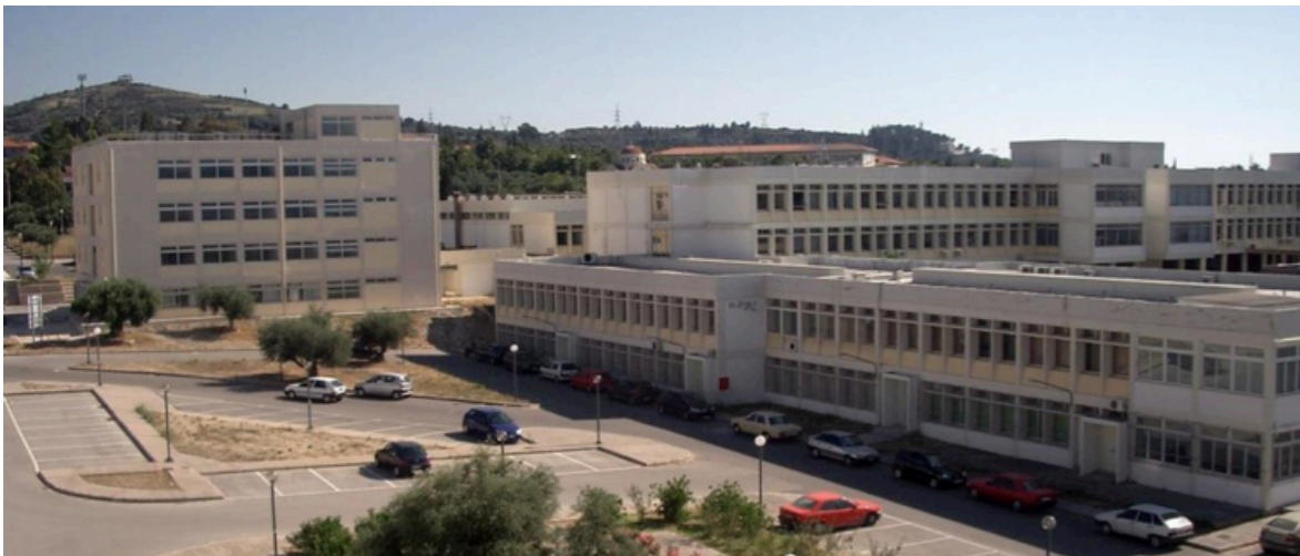
Σχήμα 1.1: Βορεινή όψη κτιρίων Τμήματος: Διακρίνεται δεξιά το Συγκρότημα των Κεντρικών Κτιρίων και αριστερά η Επέκταση
